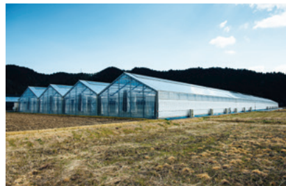
03年、80aの敷地に7450㎡のハウスを設立。灌水設備も導入した。
