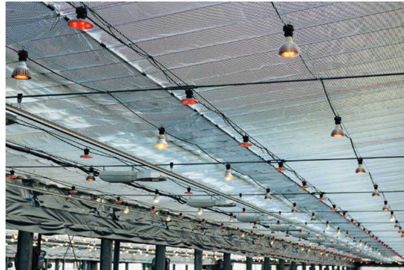
パルクボール、LED、ナトリウム灯。3種の照明を併用している。
